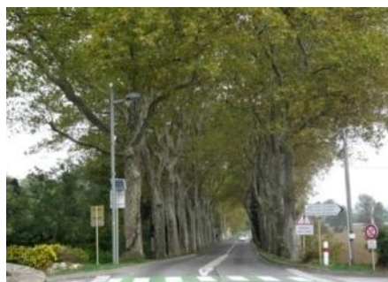
Gardouch RD 622 : arbre engageant le gabarit - Panneau « arbres inclinés » (O2.)
